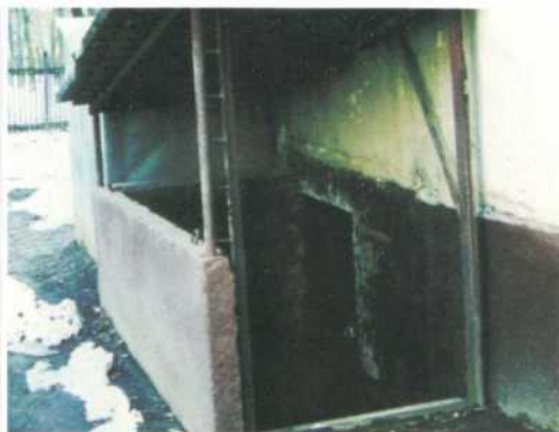
В подвале жилого дома
